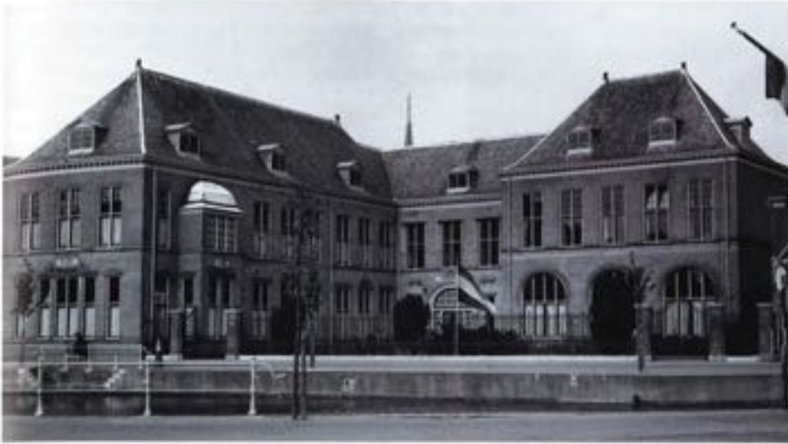
3 De voormalige universiteitsbibliotheek aan het Rapenburg, gebouwd rond 1910 en hier gefotografeerd in 1949 (A. van Vliet). Achter het rechterbouwdeel is de oude vijftiende-eeuwse kapel van het Faliebagijnhof gelegen die in 1593 door de universiteit in gebruik genomen werd als bibliotheek. Vanaf 1999 is het complex in bezit genomen door het universiteitsbestuur. (ELO)
